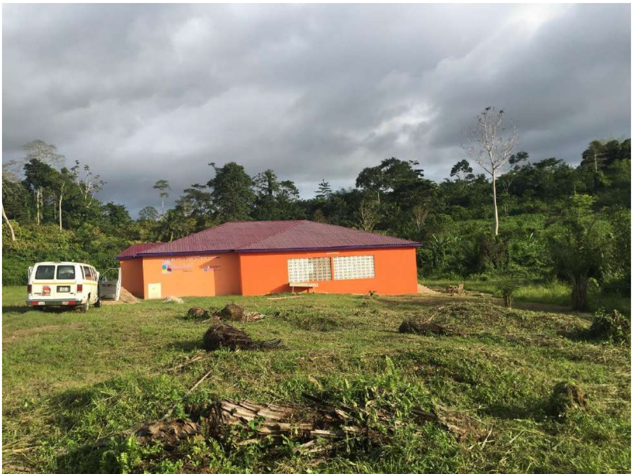
Foto : Rhiza investeert in de lokale leefgemeenschappen. Het bovenstaande schoolgebouw is voor 100% door de lokale leefgemeenschap van Jukwa Mfuom gebouwd.
